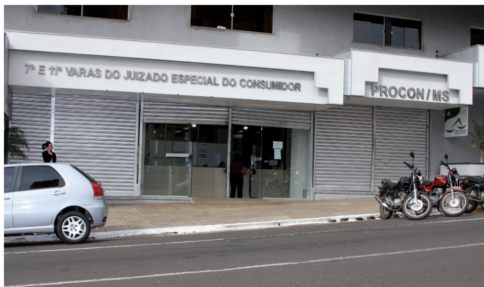
Fachada das 7ª e 11ª varas dos Juizados Especiais
