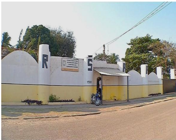
Aspecto da fachada do Estabelecimento Penal de Regime Semiaberto, Aberto e de Assistência aos Albergados de Corumbá - EPRSAAC, instalado em uma antiga estrutura alugada que serviu a um motel.
