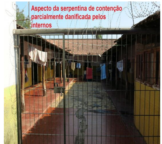
Aspecto da entrada do solário dos alojamentos do presídio de regime semiaberto masculino de Corumbá - 27/09/2017
