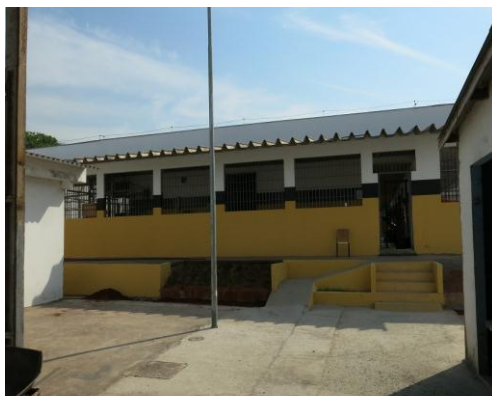
Aspecto da entrada do novo pavilhão (03) da Penitenciária de Corumbá - 26/09/2016
